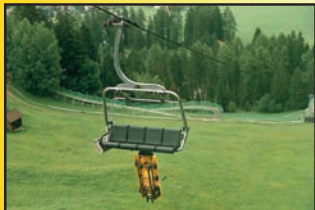
Automatyczny system transportu kolejami krzesełkowymi
